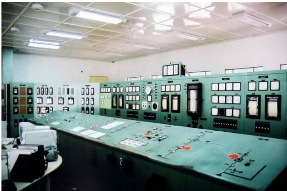
Figura 3: Antiga sala de controle (Canastra, RS). Fonte: (DACIOLE, 2009).
